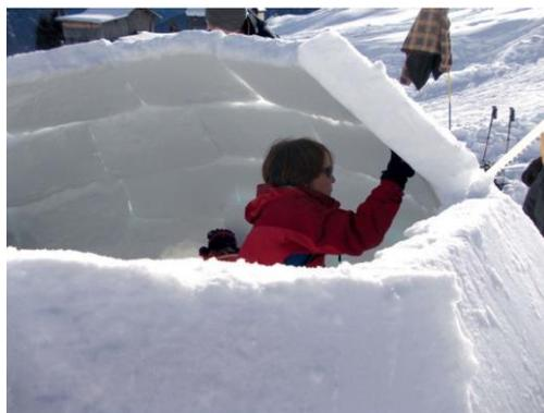
Il metodo migliore è posizionare i mattoni a due a due stando all'interno della costruzione. I mattoni
